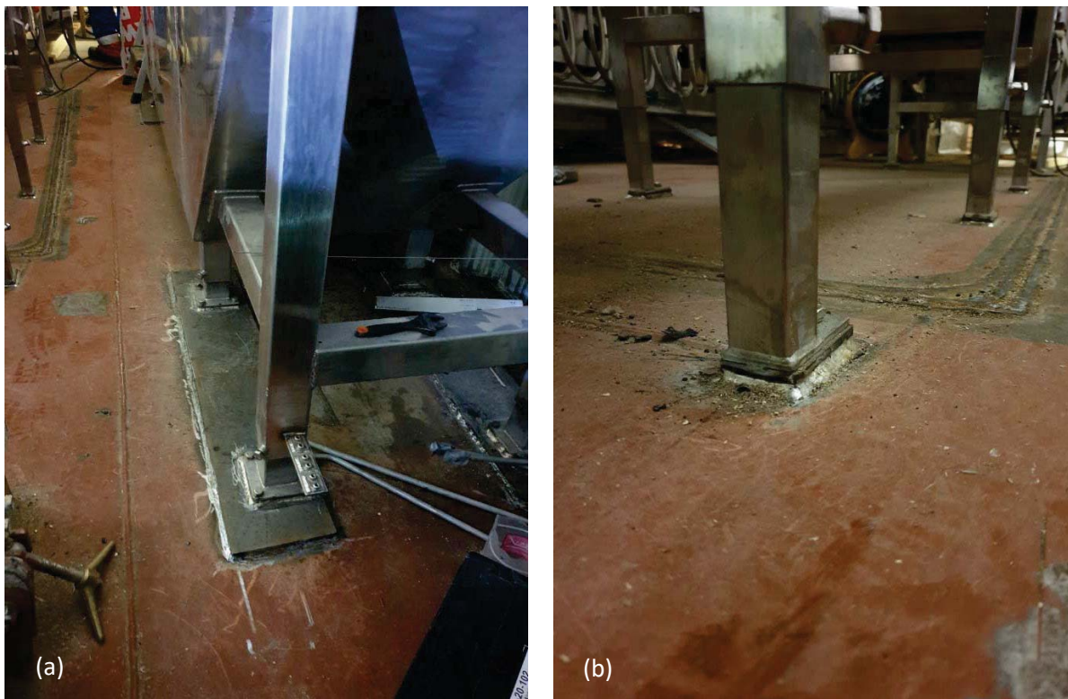
Figur 26. Umalt a) festeplate i karbonstål og b) bein i rustfritt stål
