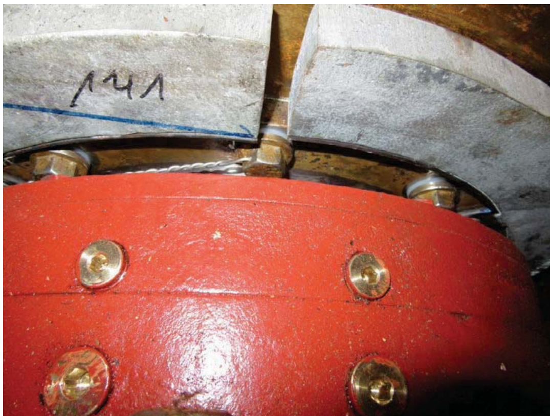
Figur 22. Reparert hylsetetning med sinkanoder
